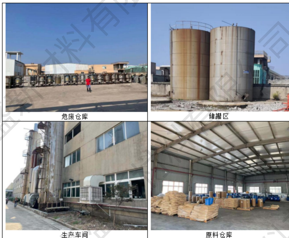
图5.1-1重点场所及重点设施设备现场照片
